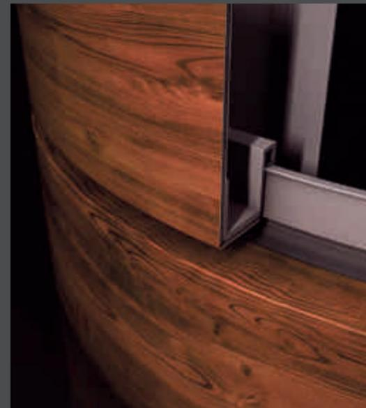
ALUCOBOND® composite panels provide an elegant and dimensionally stable solution even for tight corners or curves on buildings. All photos: Wohrlab | Die ALUCOBOND® Verbundplatten zeichnen auch enge Krümmungen am Gebäude elegant und formstabil nach.
