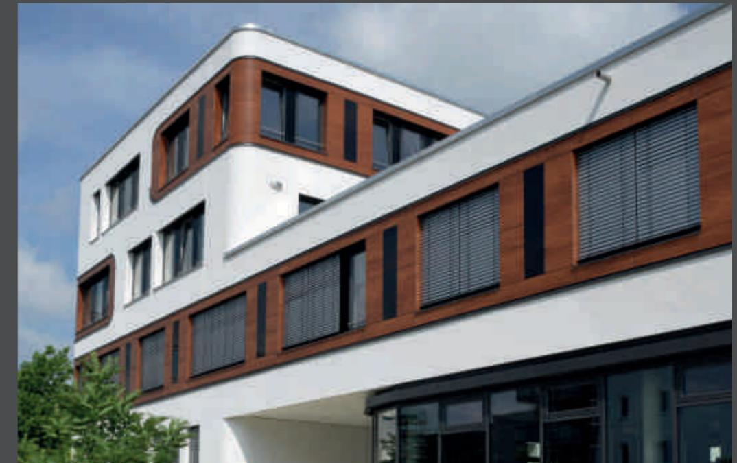
Delicate relief or flush with the façade? Thanks to thin ALUCOBOND® composite panels, it is the architectural concept which dictates the appearance of the building. | Zartes Relief oder fassadenbündig? Dank der dünnen ALUCOBOND® Verbundplatten bestimmt die architektonische Idee die Gebäudeansicht.
